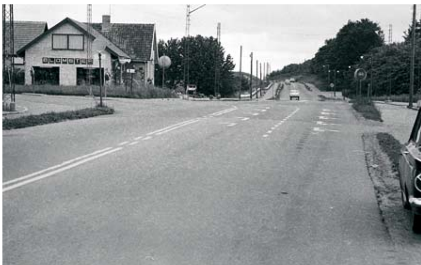
200 meter til venstre for blomsterforretningen ligger forfatterens barndomshjem, og herfra kunne han op gennem halvferdserne og firserne opleve den voksende trafikstrøm i Horsens. Da billedet blev taget, kom den sydgående trafik fra byen bag fra fotografen og drejede til venstre. Først i 1973 blev der anlagt en omfartsvej i billedets højre side.
