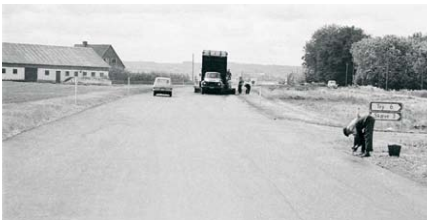
I nærheden af Dybvad, hvor en sidevej førte til landsbyerne Try og Skæve, var der asfaltarbejde midt i en kurve, hvilket bestemt ikke gjorde oversigtsforholdene og dermed trafikikkerheden bedre.
