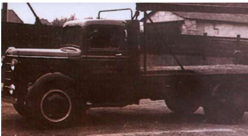
Så er vi nået til Bedford'ens æra. Her en fra 1939 fotograferet midt i halvtresserne. Billedet er interessant fordi lastvognen har monteret en garnvinde med direkte træk på bilens transmission. Bedstefar var først i Danmark med denne løsning. Med den kunne fiskegarn hentes op fra fiskekuttere og lægges ud i lynbakkerne til tørre og visa versa.
