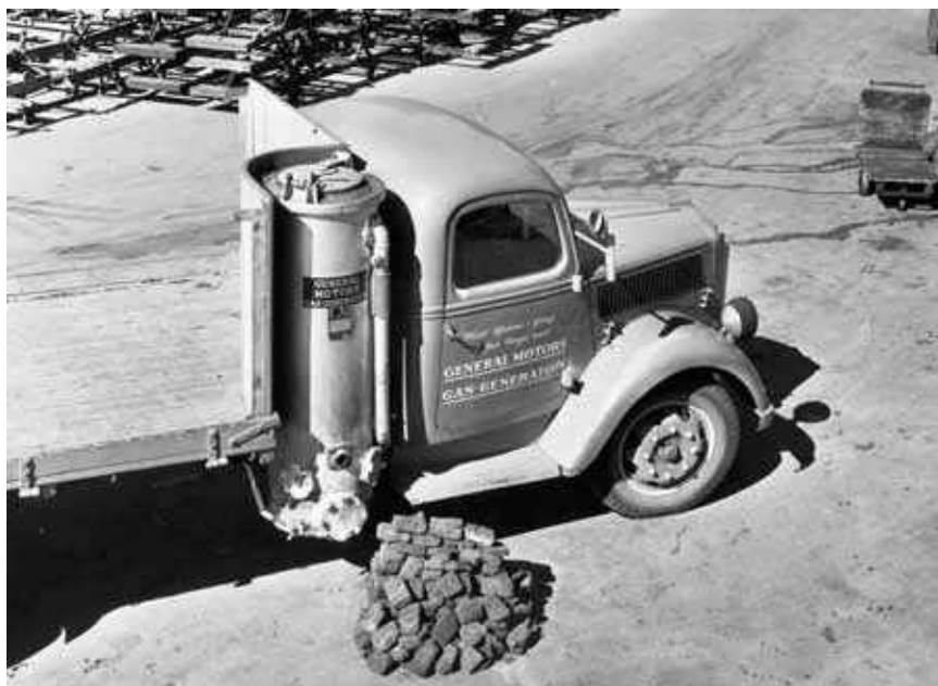
Opel Blitz med GM-Imbert generator, demobil.
