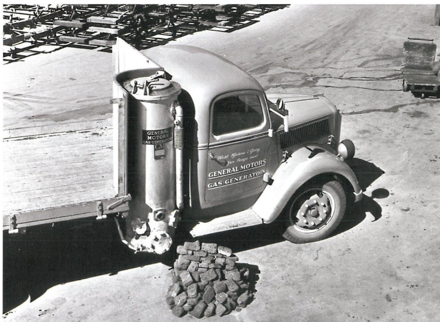
Opel Blitz med GM-Imbert generator, demobil.
