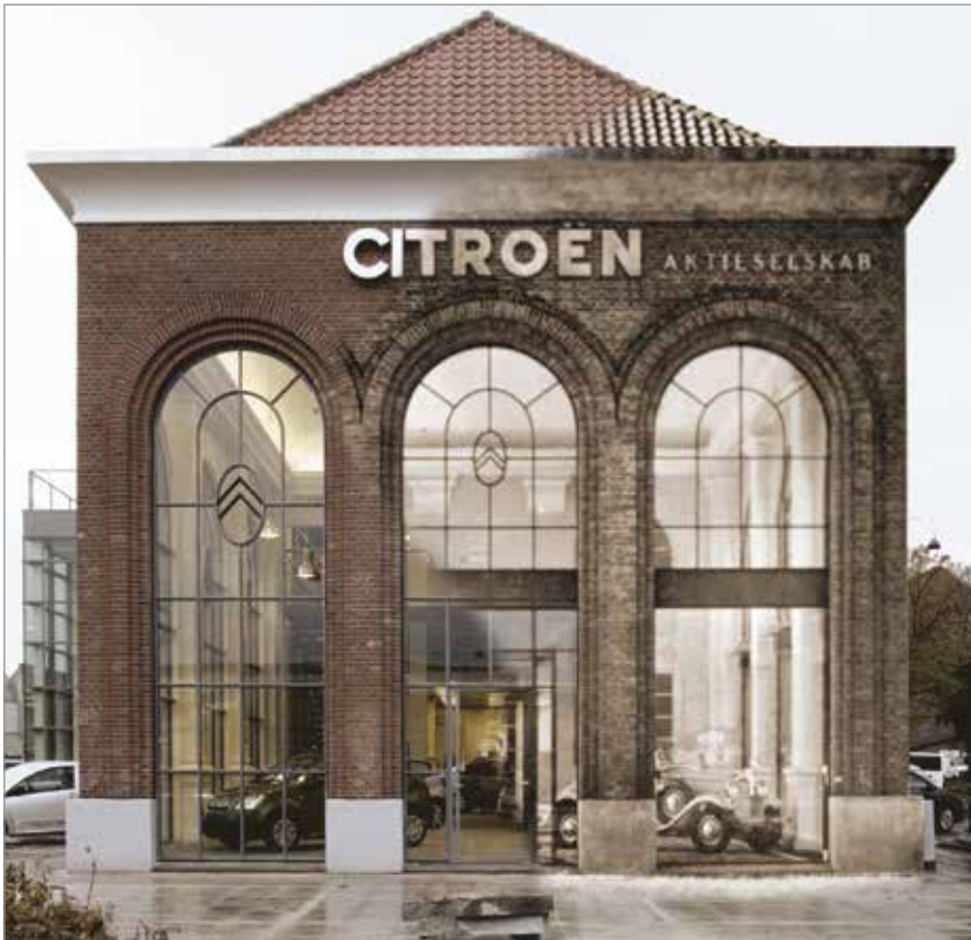
Udstillingshallen er den eneste bevarede bygning i det oprindelige Citroën-kompleks i Københavns Sydhavn. Til venstre som det så ud i 2002 – til højre omkring 1929. Fotoshopcollage: jmn.
