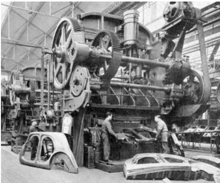
De amerikanske presser var seriøst isenkram! Her gælder det venstre halvdel af karrosserierne. Bemærk stakken på gulvet.
