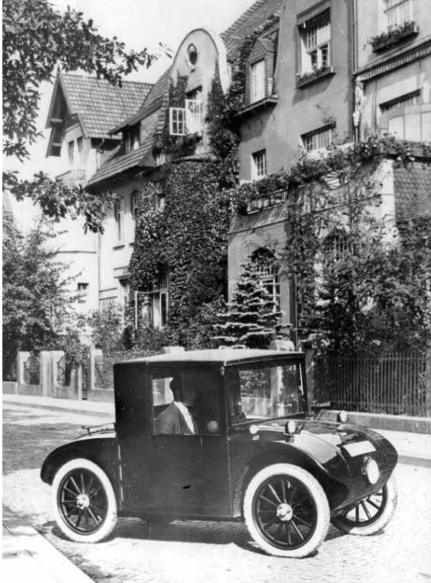
Et tidligt fabriksfoto af den lukkede model. De første biler havde en enkel udformning med glatte skærme, som en meget integreret del af karrosseriet. Snart efter kom skærmene med profileringer i – måske ikke helt så fikst, men til gengæld var de nemmere at af- og påmontere. Billedet af den åbne bil på forsiden af dette VeteranTidende er også et af de tidligste reklamefotos fra fabrikken.
