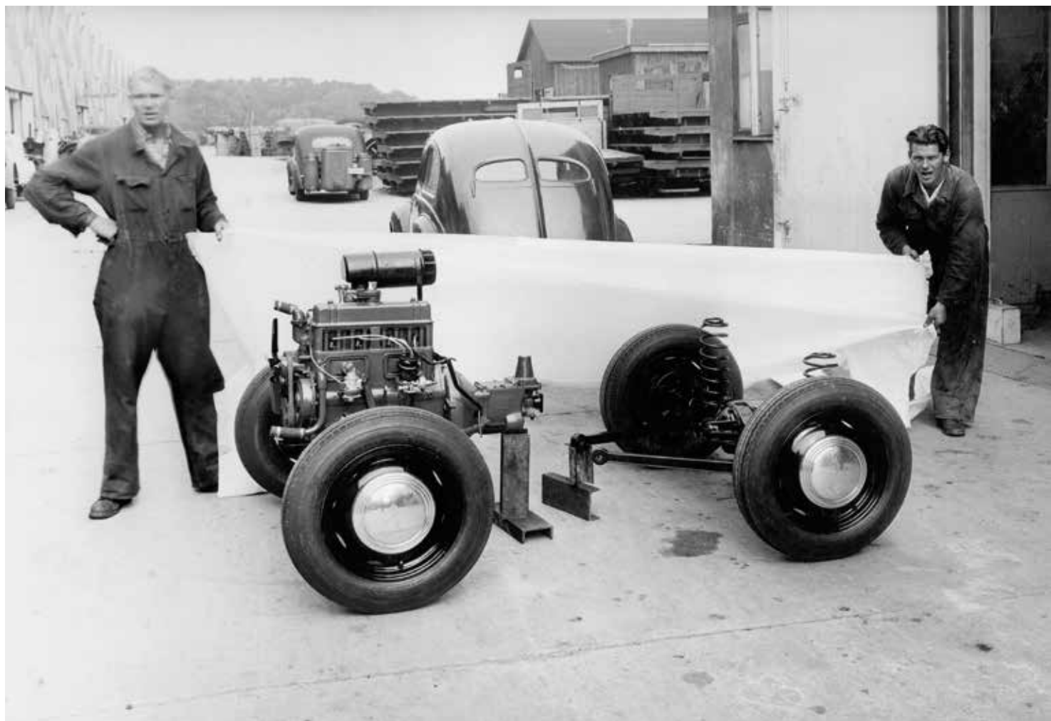
En opstilling af for- og bagaksler til Volvo PV 444. Bag lagenet ses den Hanomag 1,3 som Volvo erhvervede for at undersøge opbygningen af bilens selv bærende karrosseri. Længere væk ses en Volvo med gengas-apparat, der understreger at billedet er fra under Anden Verdenskrig. Foto fra Volvo Museets historiske arkiv.
