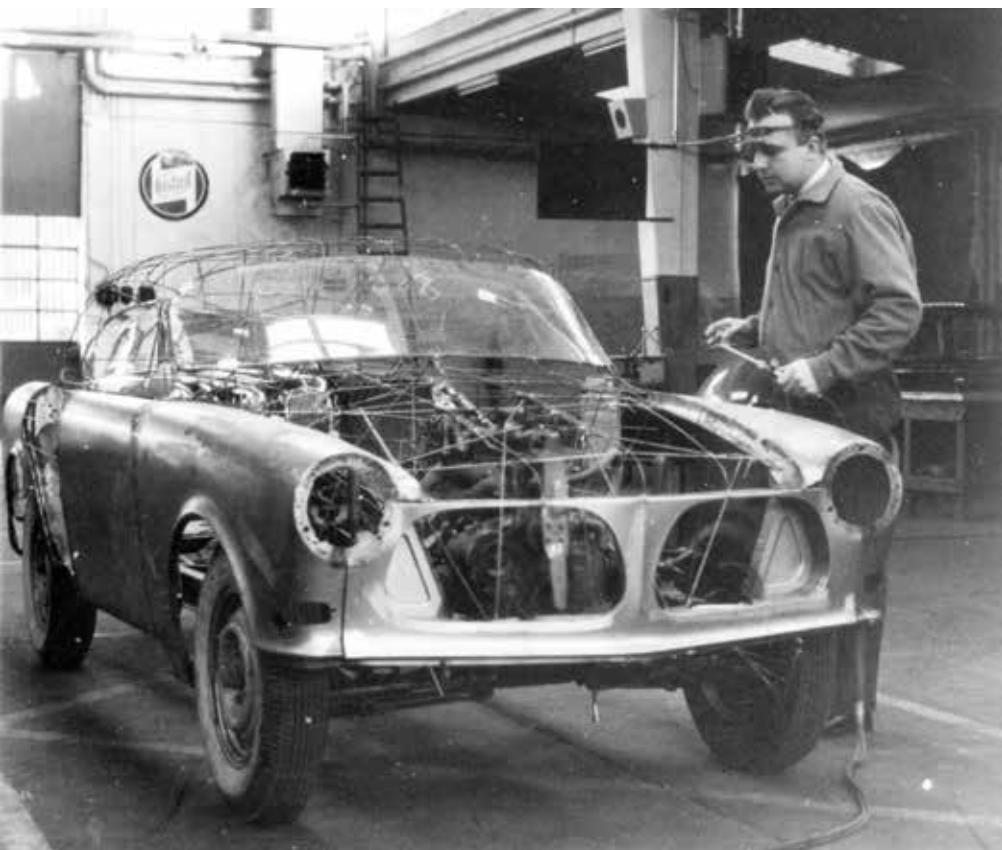
1959. Ole Sommer svinger gasbrænderen og bygger bil. I første omgang som en gittermodel forud for fremstillingen af de rigtige karrosseridele. Øverst til højre ses Ole Sommer i én af sine yndlingsbiler, Jaguar Type D, som blev købt i 1976.
