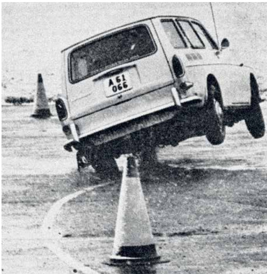
Foto fra svenske biljournalisters opsigtsvækkende demonstration i 1968 af, hvordan enkeltleddede drivaksler kan føre til væltning ved hurtig kørsel i sving. Det yderste baghjul ses tydeligt trukket ind under bilen. Væltning blev undgået, fordi køreren var forberedt og kunne afværge den ved at styre kraftigt kontra. Bilen er en VW 1600, der først senere fik kardanled i begge ender af drivakslerne. Demonstrationen førte til, at risikoen for væltning med simple pendulaksler blev almindelig kendt.
