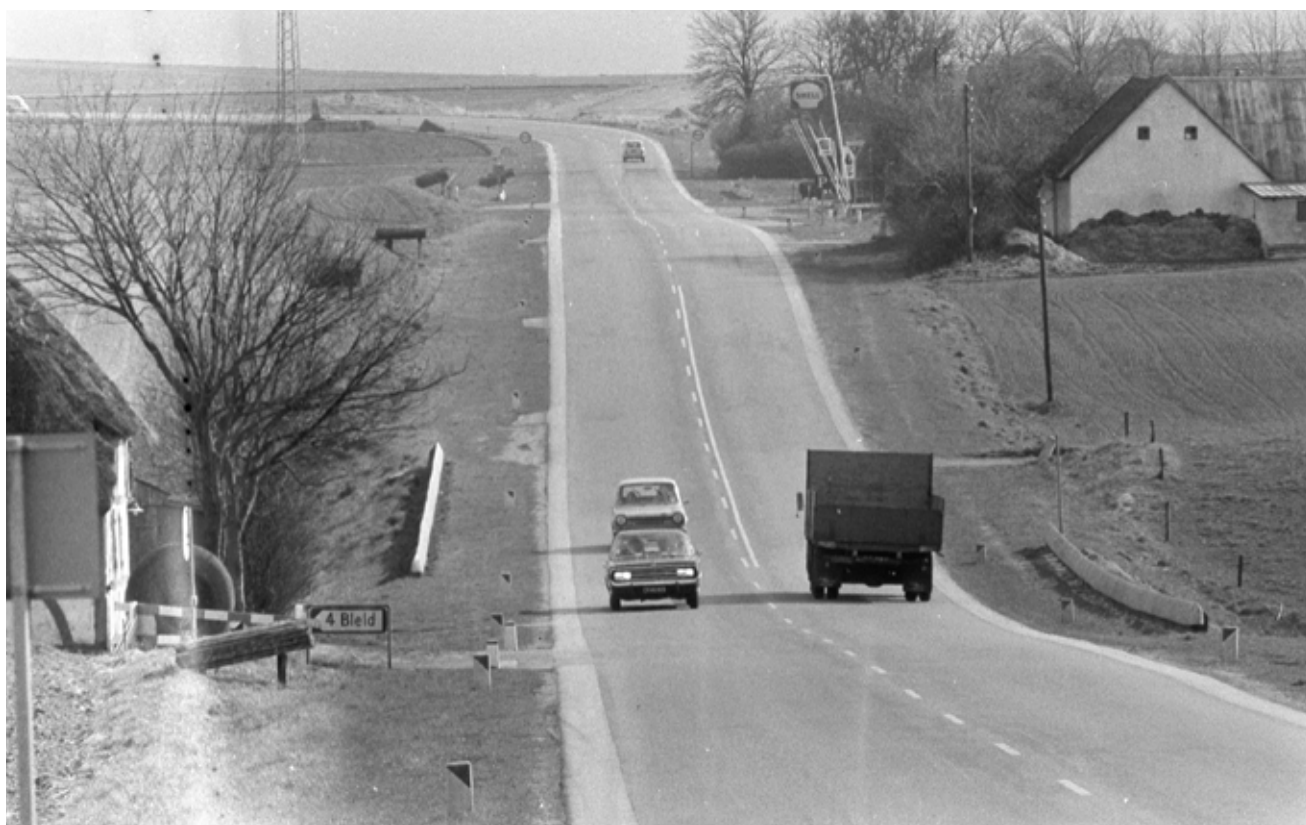
Nord for Horsens lurer der ved Gedved flere farer: Højdeforskelle. En lang kurve. En Shell-tank med trafik ind og ud samt ikke mindst bivejen til landsbyen Bleid, hvor der fra Horsens-siden ikke er nogen højresvingbås.
