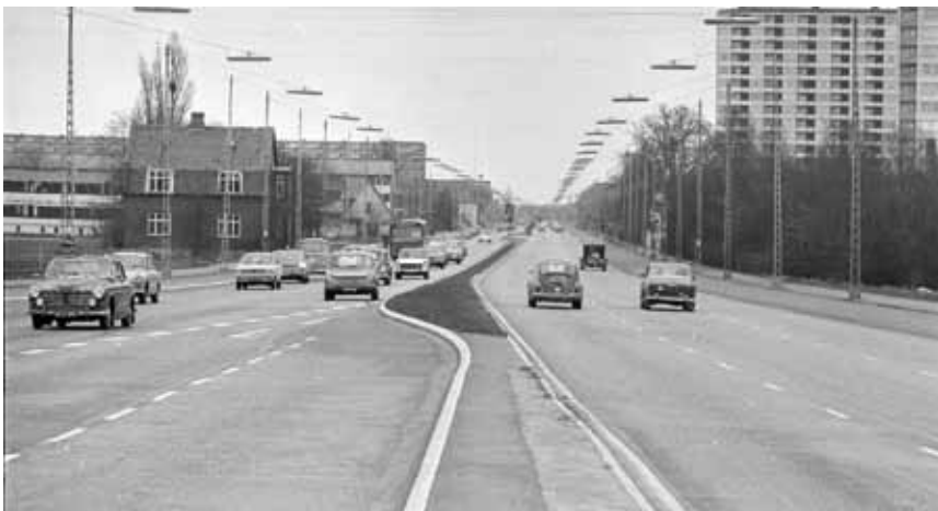
Roskildevej med sine mange boligblokke på begge sider udgjorde i 1973 den første del af hovedvej A1.
