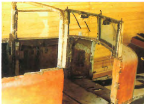
Det viste sig at det meste af kalechestativet og de vigtigste beslag var i behold under det faste tag. Jens Nielsen lavede tegninger til rekonstruktion af det manglende. Også meget af pladerne og af træværket, især i dørene, kunne bevares.
