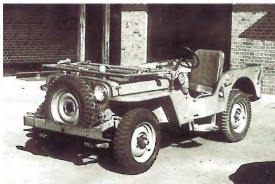
En CJ2A fra 1948. Bemærk, at Jeep'en nu har halvflyden-de bagaksel, benzinpåfyldning på siden og trinbræt, som letter indstigning betydeligt.
