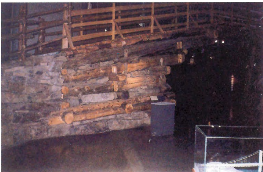
Bro af natursten – træstillads rejses. Det afdækkes med sandsække. Sten sættes fra begge sider. Afsluttes med kilesten i midten. Træstilladset fjernes.
