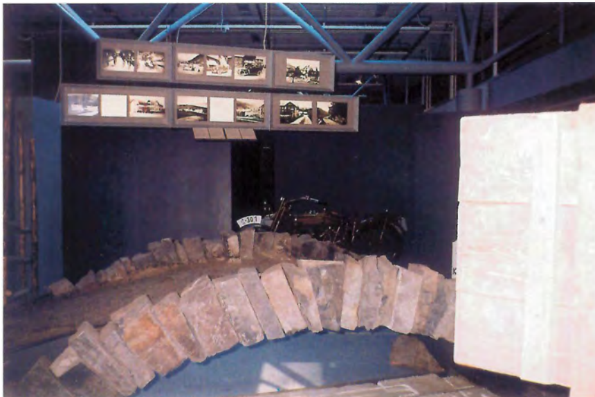
Bro af natursten – træstillads rejses. Det afdækkes med sandsække. Sten sættes fra begge sider. Afsluttes med kilesten i midten. Træstilladset fjernes.
