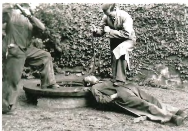
Skæg blev der også lavet på værkstedet. Knudsen er lagt på en bagagebærer, Nissen står med smedetangen, og Tiedemann er klar med forhammeren. Den runde indretning må være et levn fra amtsbanetiden.
