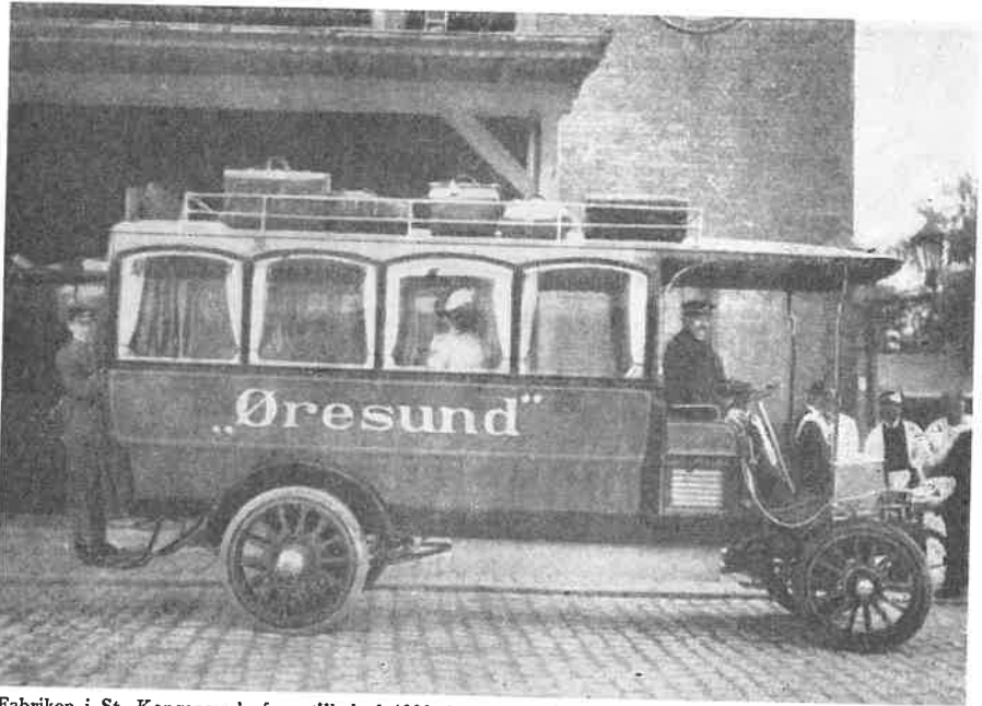
Fabriken i St. Kongensgade fremstillede i 1906 denne elektriske omnibus til forbindelsen mellem Københavns Hovedbanegård og Havnegade, hvor den var i brug næsten lige til første verdenskrig.
