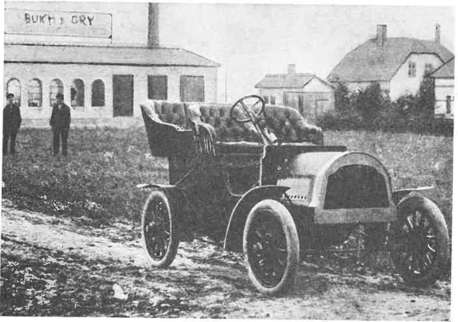
Øverst på siden: Bukk-bilen, der blev fremstillet i en landsbysmedie i Nordvestsjælland, var højmoderne efter datidens forhold. Motoren var 2-cylindret. Den havde topventiler til insugning og sideventiler til udstødning.
