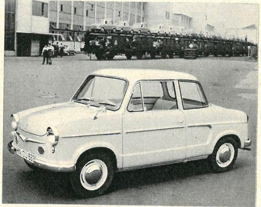
**PRINZ II (E)** mit Vollsynchrongetriebe und Komfortausstattung, Drehfenstern, Liegesitzen, weiterer Geräuschdämpfung usw.
