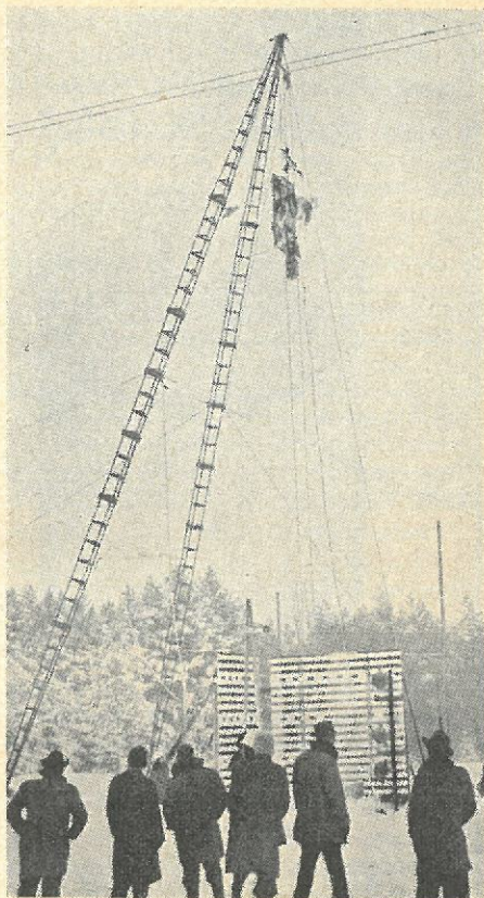
Ved forsøgene benyttede man blandt andet en dukke fastspændt til et særligt sæde, som blev hejst op i det viste „tårn“. Ved fotografiske optagelser kunne bevægelse og tid følges, da en skala-inddelt skærm dannede baggrund.
