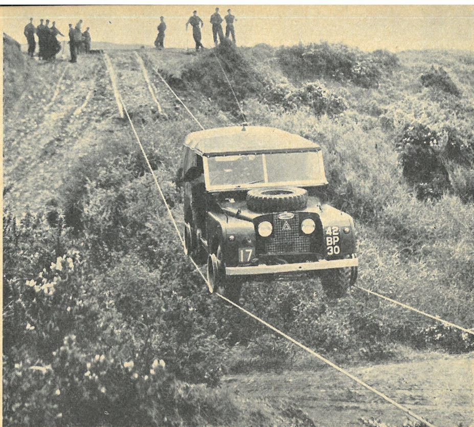
I den engelske hær har man udført vellykkede eksperimenter med lynhurtig brobygning på denne måde. Med specielle remskiver på hjulene kører de lettere vogne over afgrunden på to ståltrosser. Der foreligger ikke noget om, hvorvidt infanteriet skal lære at gå på line, men onde tunger påstår, at er derfor, den engelske soldat er blevet udstyret med paraply. Efter sigende overvejer trafikministeren at klare situationen ved Lillebælt på denne måde.
