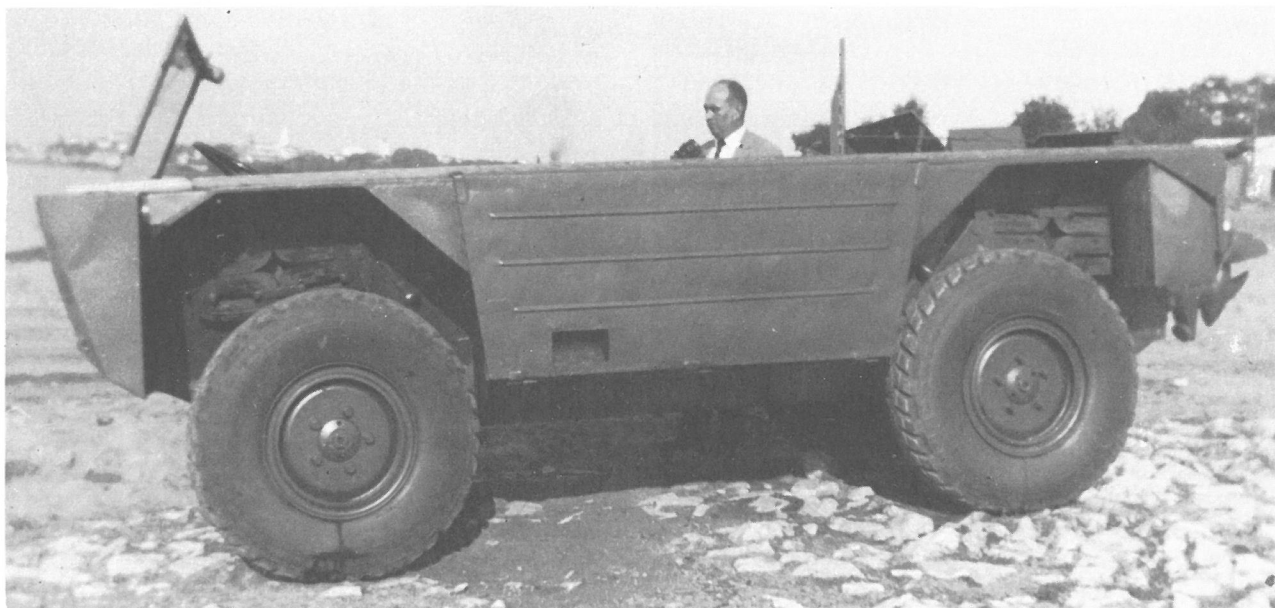
Le prototype entièrement amphibie du VB-100 au bord de la Loire. Il était doté d'une étrave à l'avant et d'une hélice à l'arrière. Collection Bouffort.
