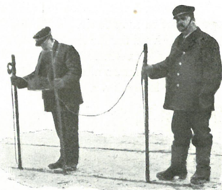
Maaling af Modstand i Skinnestod.
