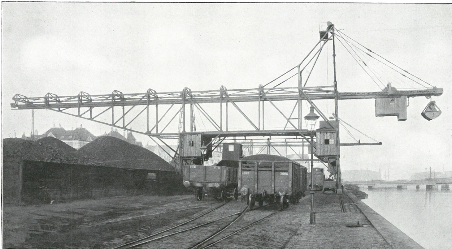
Fig. 1. Kulkran ved Kalvebodbryggen.
