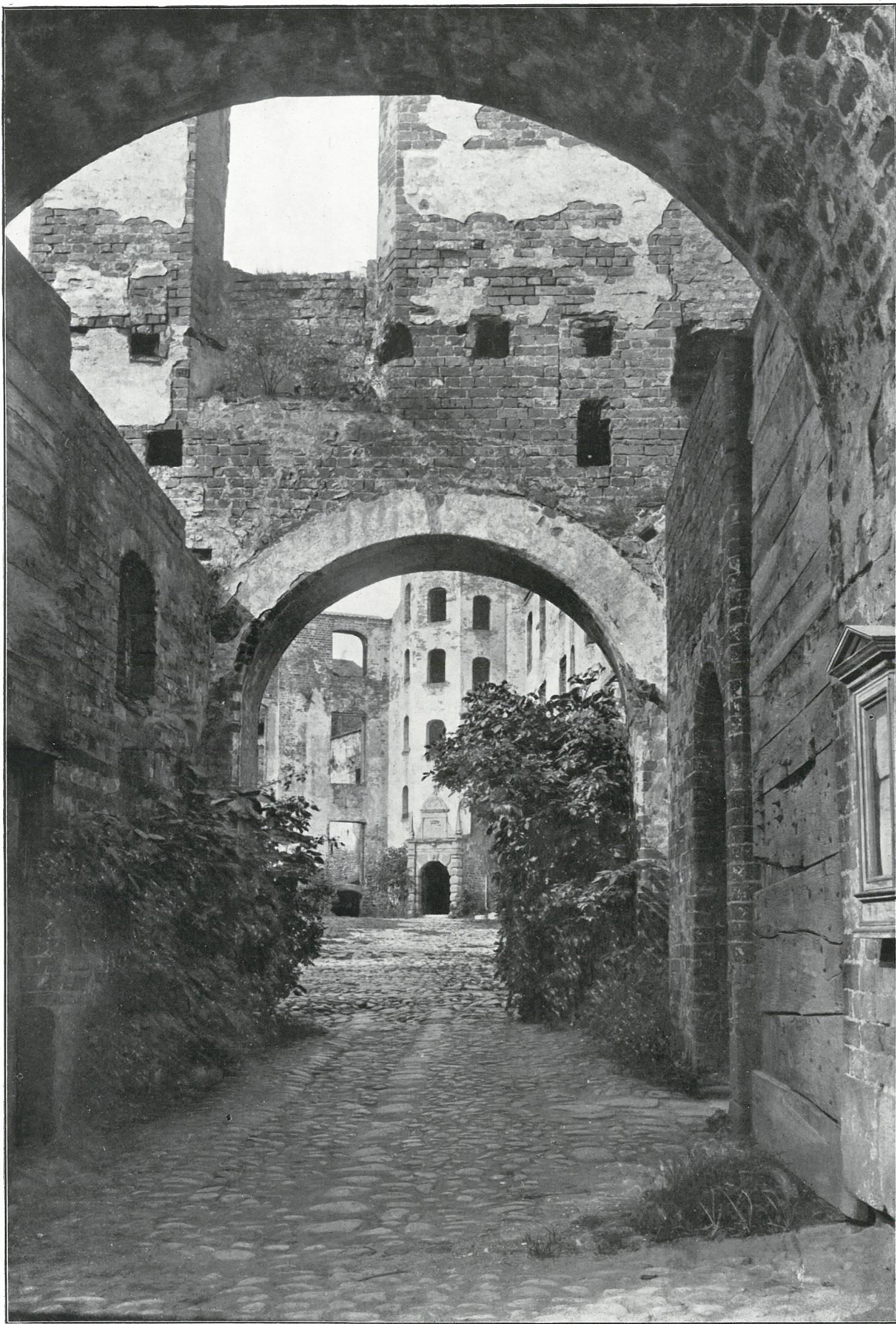
Kolding Slotsruiner (Portaabningen).
