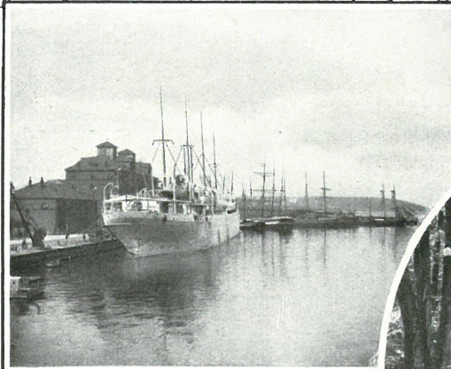
Danmarks smukkeste Motorskib „Fiona“ ved Havnepakhuset. I Baggrunden Riis-Skov.
