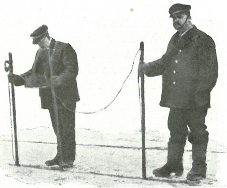
Maaling af Modstand i Skinnestod.
