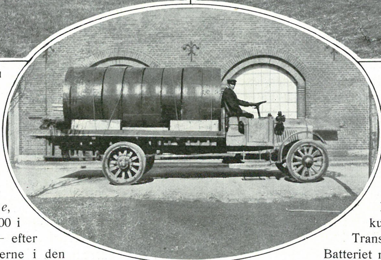
Et Lastautomobil med brede Hjulringe, som skydes ind over Kanonhjulene, naar Kanonerne skal transporteres hen over blød eller sandet Markjord.
